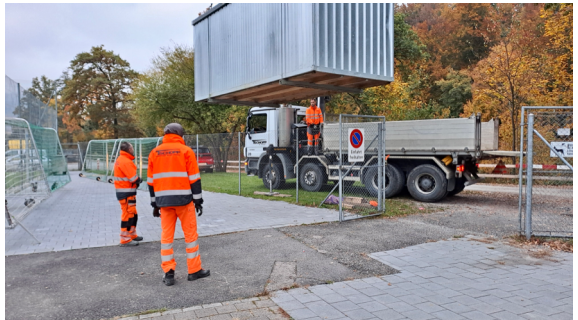
„Grosses Geschütz“ wird aufgefahren, Ende der Herbstferien, durch die Bau-Unternehmung Tschopp
